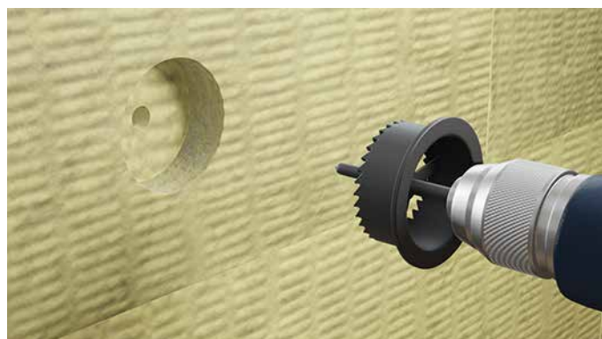
RYS.21 Frezowanie otworu w płycie z wełny mineralnej
