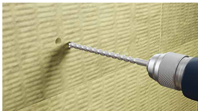
RYS.20 Wykonanie otworu w wełnie i podłożu
