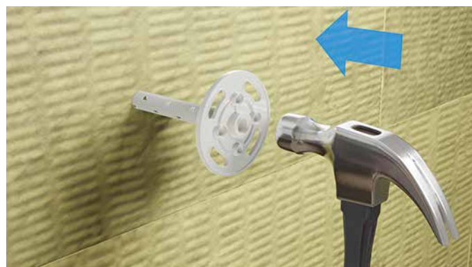
RYS.16 Umieszczenie łącznika w nawierconym otworze
