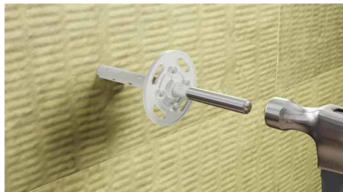
RYS.17 Wbicie trzpienia w tuleję łącznika
