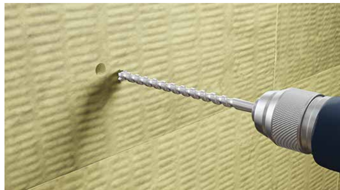
RYS.15 Wykonanie otworu w płycie z wełny i podłożu
