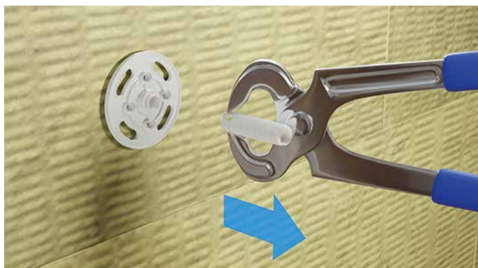
RYS.19 Odcięcie wystającej części tulei
